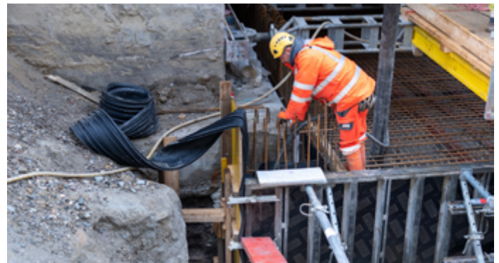
Die Vorbereitungen für den Stollenbau haben bereits begonnen.
