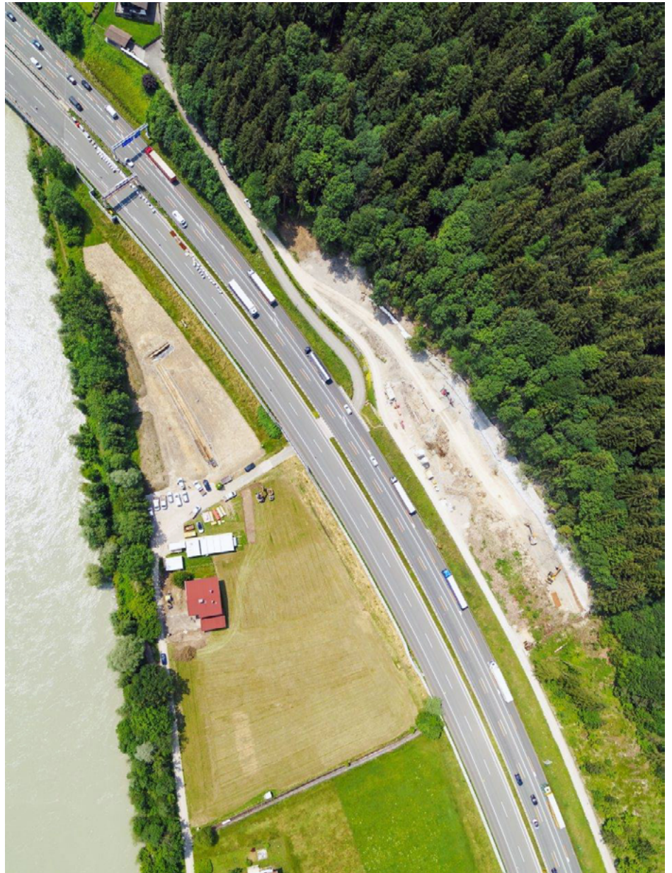
Entlang der Inntalautobahn errichten die ÖBB eine temporäre Zufahrtsstraße.
