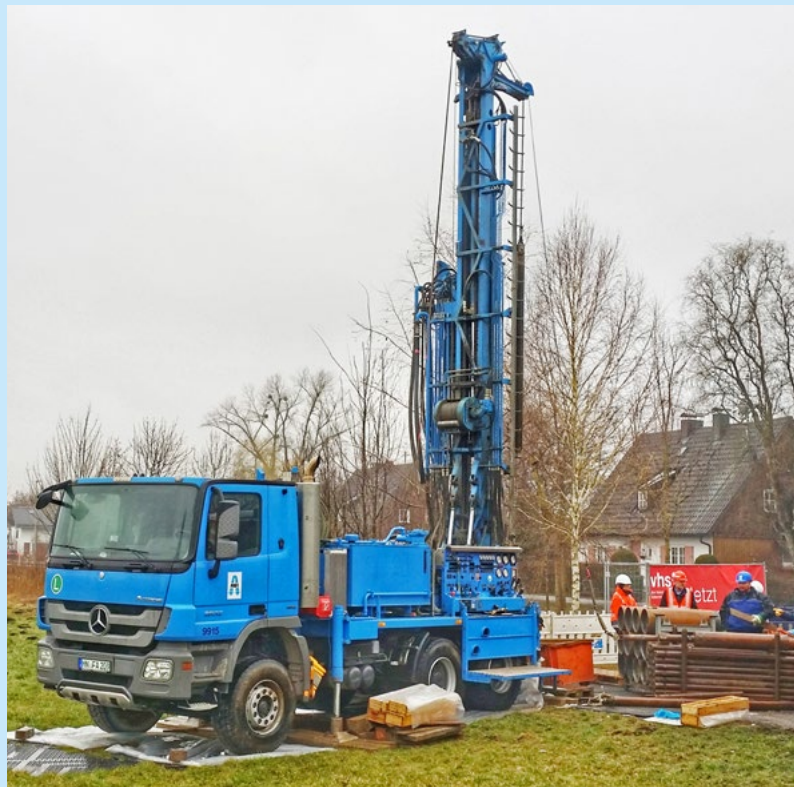
Bohrstelle in Kolbermoor: An dieser Stelle dringen die Geologen bis zu 60 Meter tief ins Erdreich vor
