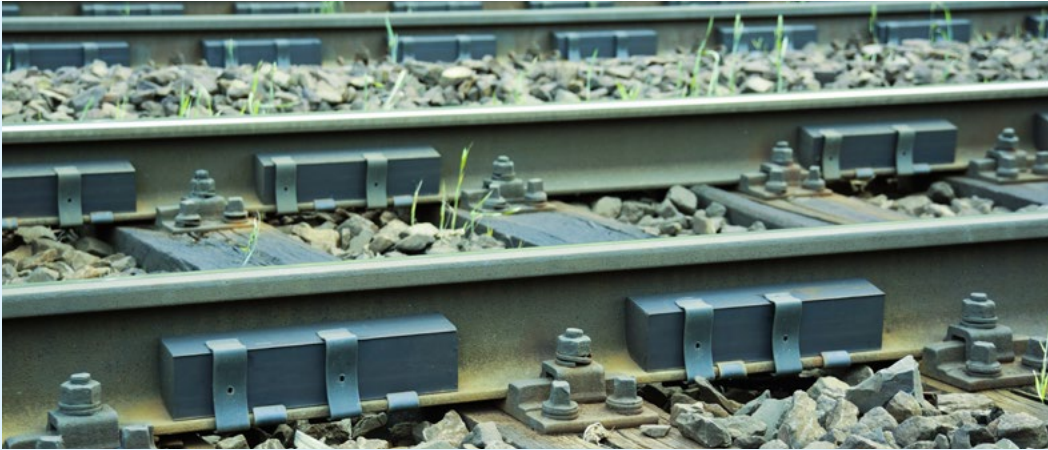
Schienenstegdämpfer wirken direkt am Gleis – dort, wo der Schall entsteht. Sie reduzieren den Lärm um 2 bis 3 Dezibel.
